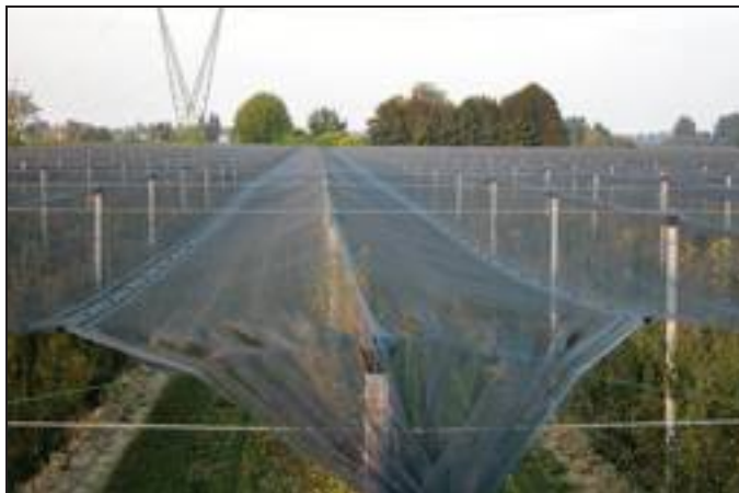
[ Impianto a reti semipiane visto dall'alto. È visibile la fune trasversale al di sopra della rete.
